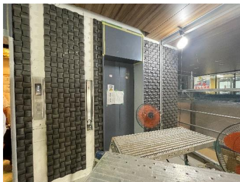
エレベーター周辺
